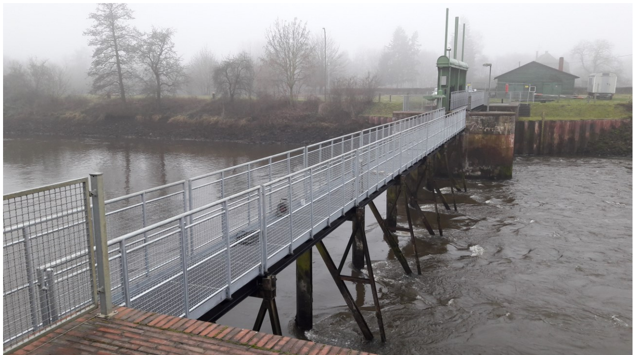
Wehranlage Hademstorf nach Instandsetzungsarbeiten (Foto: WSA Verden)
