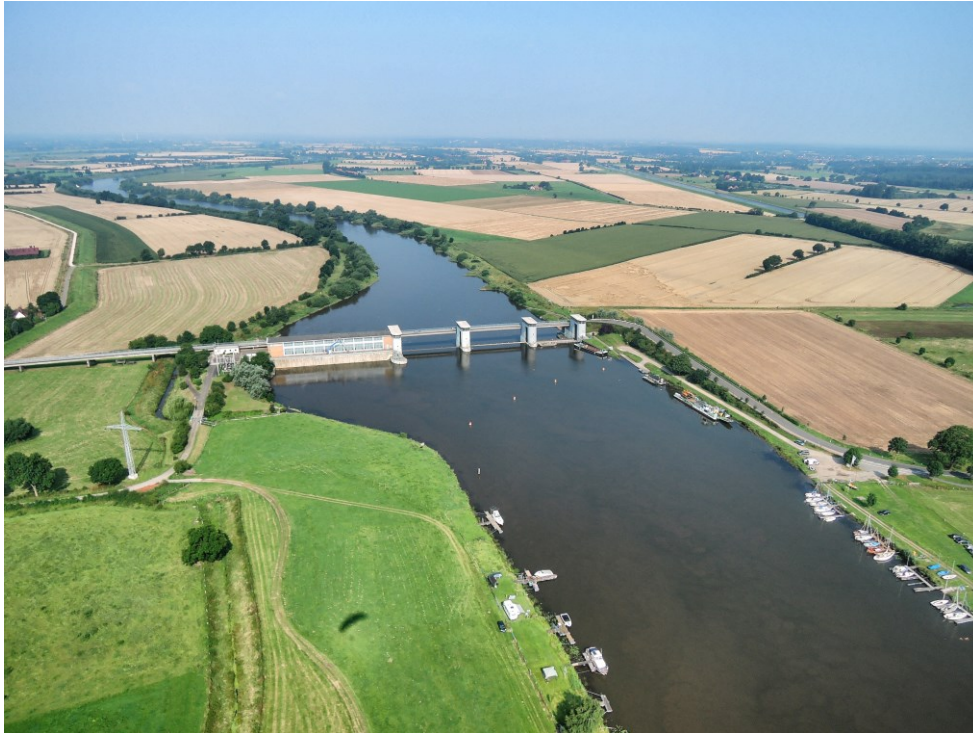
Der Brückenzug über das Wehr Intschede. Er soll ab 2019 durch einen neuen Überbau ersetzt werden (Foto: WSA)
