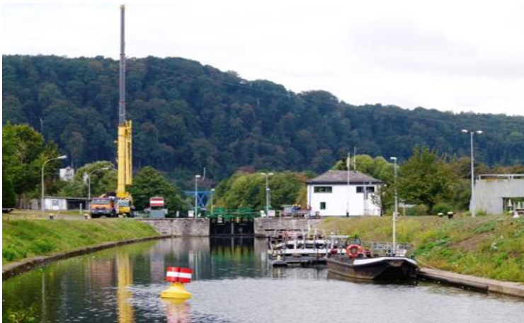
Blick auf die Schleuse Güdingen vom Oberwasser
