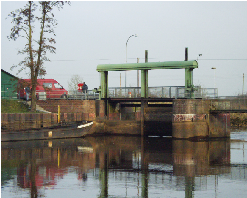
Instandsetzung der Wehranlage Hademstorf, Erneuerung der Wehrstege und der Hubschütze. (Foto: WSA)
