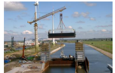
Montage eines Schleusentores
