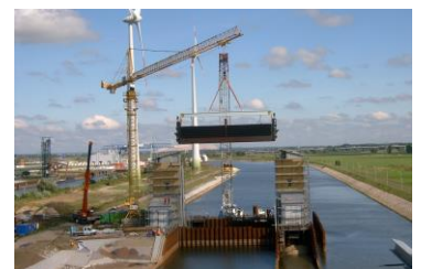
Montage eines Schleusentores
