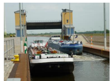
Schleuse im Betrieb
