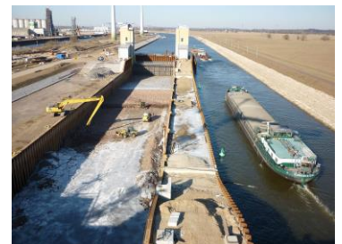
Blick in die Baugrube
