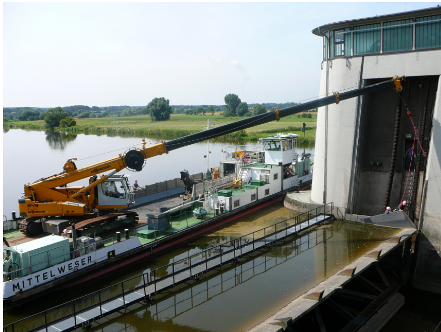
Instandsetzungsarbeiten am Wehr Schlüsselburg, hier ein Archivfoto Foto: WSA
