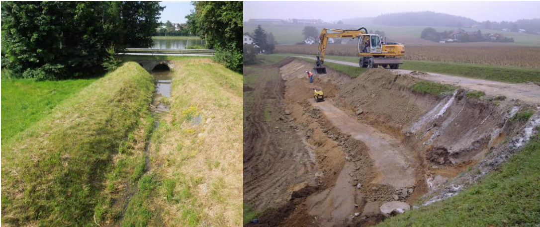
Bild 1: Baubereich Wörther Graben Quelle: WSA Nürnberg
