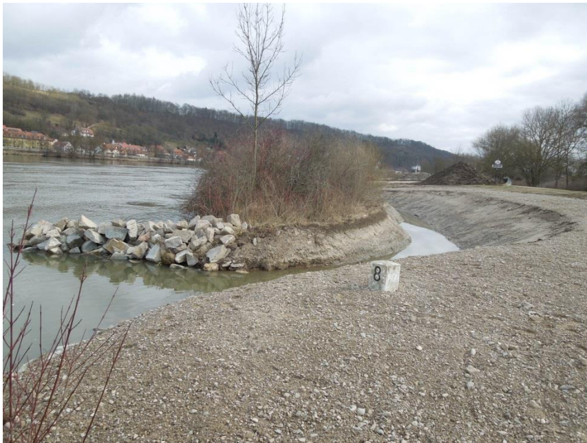
Bild: Eine der Wasserrinnen mit Insel (Gehölzbestand) während der Bauzeit
