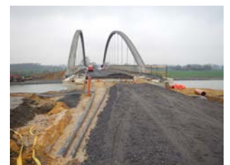
Brücke auf neuen Widerlagern in Blickrichtung Dülmen
