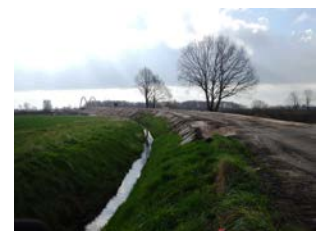
Westrampe in Blickrichtung Lüdinghausen
