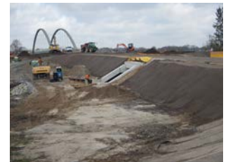
Neue Ostrampe mit Durchlass im Vordergrund
