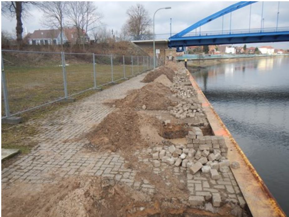
Die Binnenschiffsliegestelle zwischen der Eisenbahn- und der Straßenbrücke in Hoya Foto: WSA
