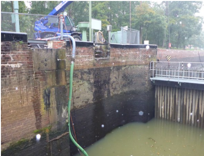
Die Schleuse Bannetze während der Bauwerksprüfung (Foto: WSA)
