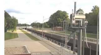
Abschlussprojekt Schleuse Hüntel
