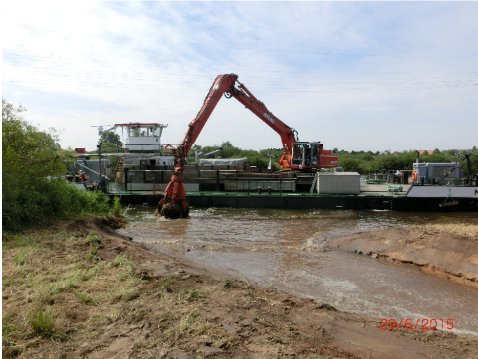
Schwimmgreifer „Minden“ der Wasser- und Schifffahrtsverwaltung im Einsatz auf der Aller bei der Maulohe (Fotos: WSA)
