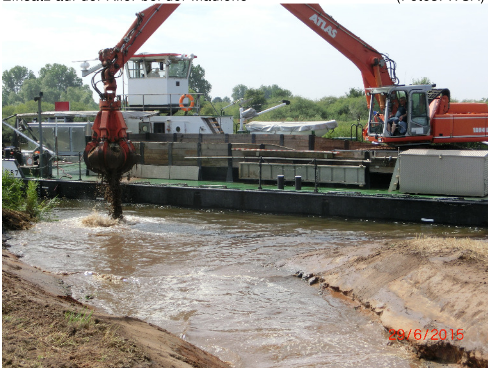
Mit vollem Greifer wird die Steinschüttung aufgenommen und abtransportiert (Fotos: WSA)
