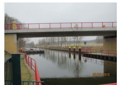
Oberer Vorhafen nach Fertigstellung
