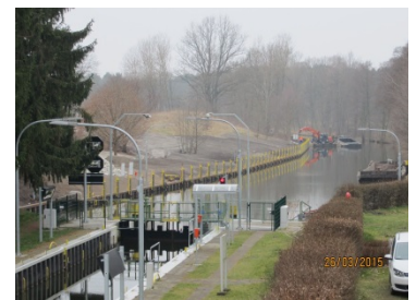
Unterer Vorhafen nach Fertigstellung
