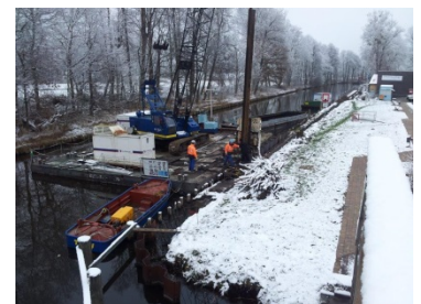
Rammarbeiten im Winter
