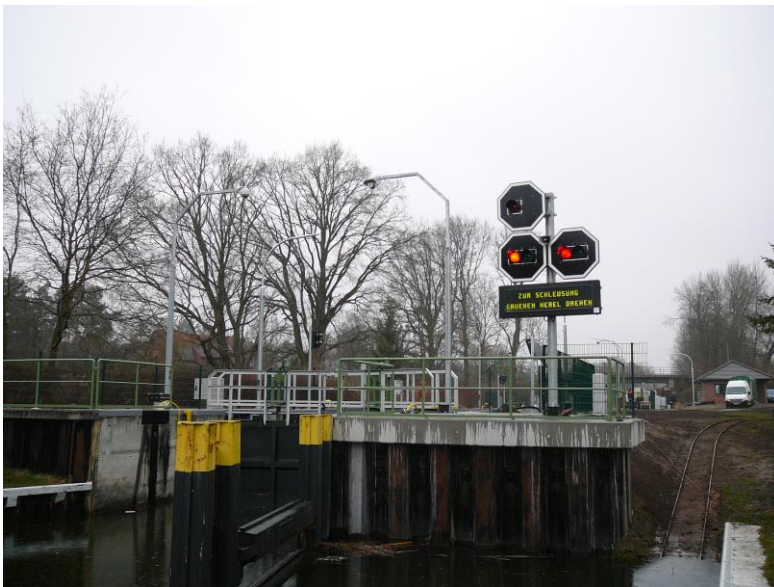
Bild 1 Schleuse Voßwinkel mit Sportbootschleppe
