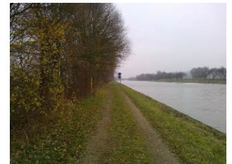
Kanaldamm mit Betriebsweg
