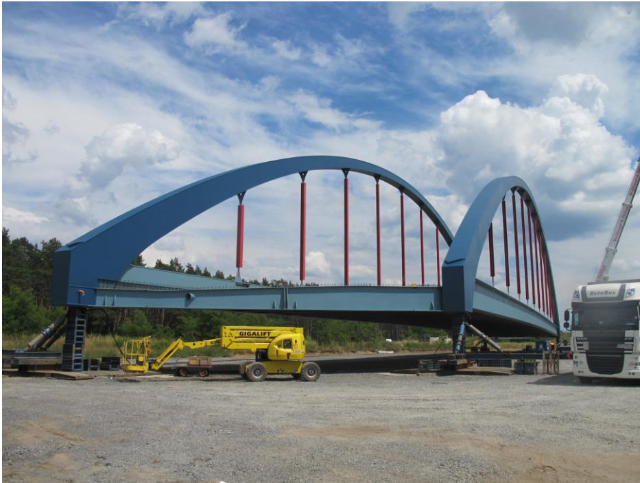
Alle Hilfskonstruktionen zur Herstellung des Überbaus wurden entfernt. Die roten Bauteile sind sogenannte Hängeraussteifungen, die ausschließlich für den Vershub benötigt werden
