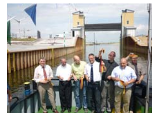
Freigabe der Durchfahrt durch die Kammer der Niedrigwasserschleuse, Juli 2011
