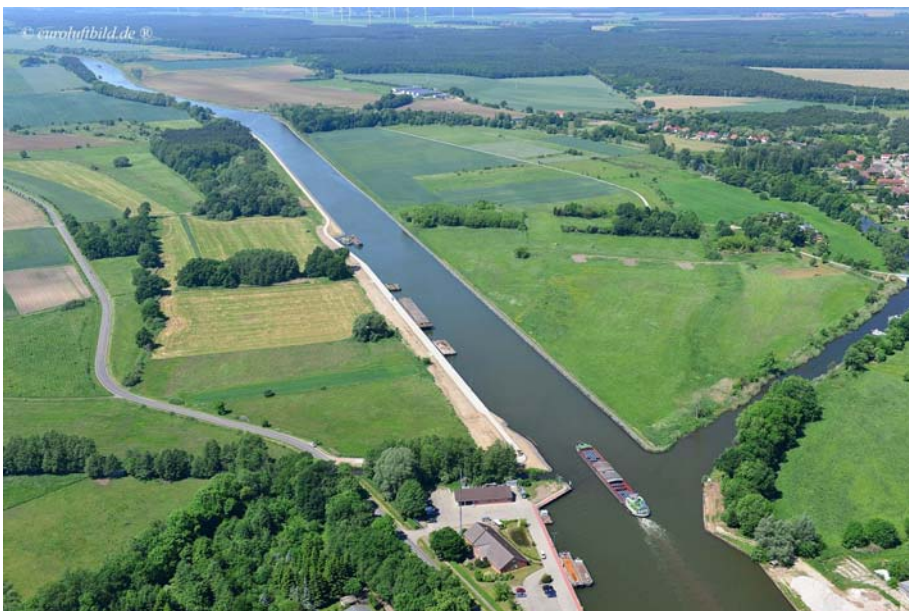
Bild1: Blick von Genthin auf den fertig gestellten Kanalabschnitt S71 gen Osten – in Bildmitte ist die neue Liegstelle für die Berufsschifffahrt zu sehen
