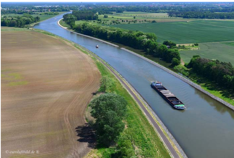
Bild 3: Fertig gestellter Kanalabschnitt S71 als Trapezprofil mit Blick Richtung Genthin
