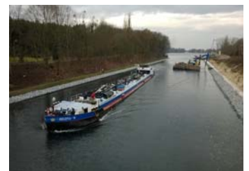
16. Januar 2014 – das Tankmotorgüterschiff Regina W passiert die Baustelle Nedlitzer Durchstich
