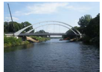
neue Nedlitzer Südbrücke
