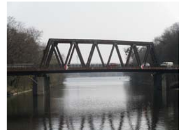
alte Nedlitzer Südbrücke
