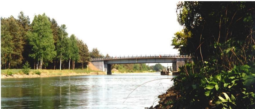
Bestandsbauwerk – Ansicht von Westen (vor der Holzung und Rodung)
