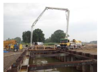
Betonage Unterwasserbe- tonsohle Unteres Wehr
