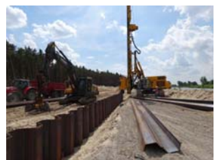
Spundwandarbeiten Oberer Vorhafen
