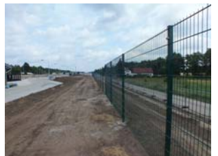
Betriebswege und Zaunanlagen
