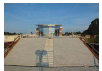
Blick auf den Steuerstand des Schleusenbetriebs- bäudes
