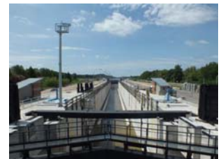
Blick von der Unterhauptbrücke in die Schleusekammer
