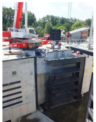
Ausheben Untertor am 05.08.2013
