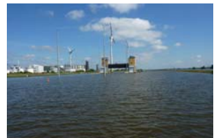
Blick vom Pumpwerk Richtung Oberhaupt und Kammer am 10. Juni
