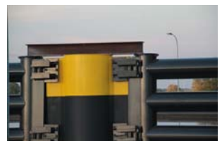
Detailsicherung der Leit- werke gegen Aus- schwimmen
