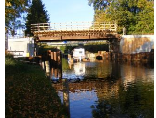
Ansicht der neuen Brücke im Bauzustand, im Hintergrund sind die wesentlich kleineren Durchfahrtsparameter der alten Brücke zu erkennen (09/2012)
