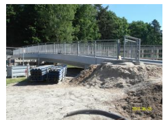
Der Ersatzneubau in den letzten Zügen.
