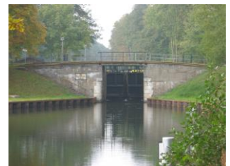
Die alte Straßenbrücke Schleuse Grafenbrück
