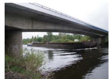
Straßenbrücke Marquardt über den Sacrow-Paretzer Kanal
