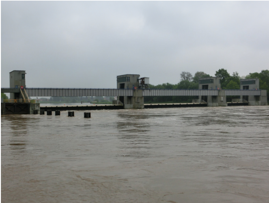
Hochwasserabfluss am Wehr Dörverden
