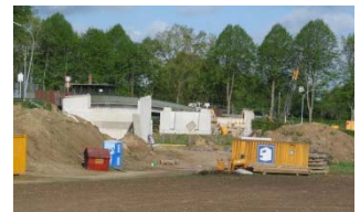
Darstellung der beiden Widerlager und des Mittelpfeilers
