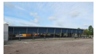
Darstellung der bereits fertiggestellten Überbauten im Hafen Lathen
