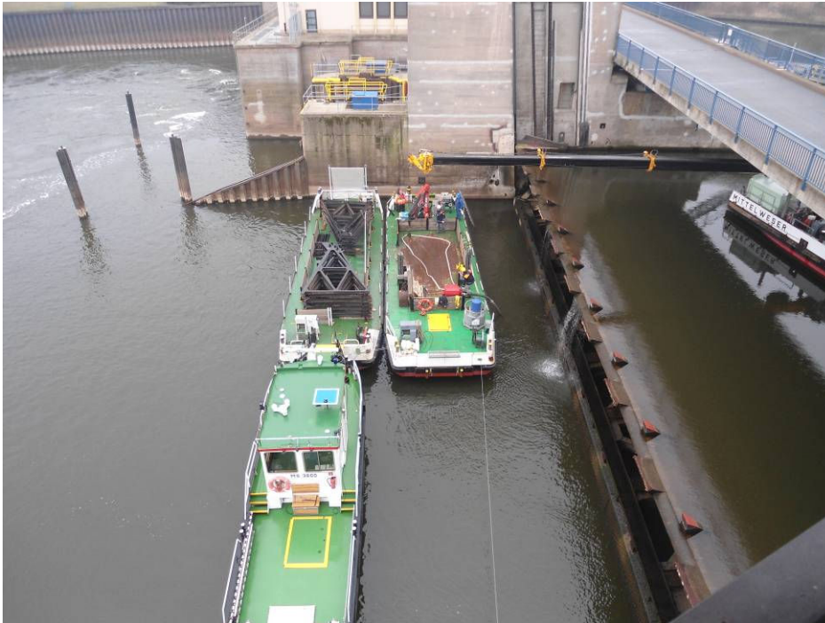
Setzen des Unterwasser-Revisionsverschlusses durch den ABz Nienburg
