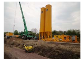
Baustelleneinrichtung Schlitzwand
