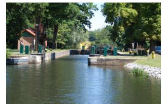
Schleuse Wolfswinkel, Finowkanal
