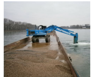
Baggerarbeiten im Rhein
