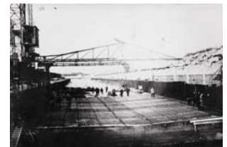
Schleusenbau 30´er Jahre letztes Jahrhundert
