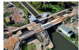
vorläufig abgeschlossener Brückenbau
