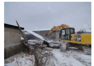
Rückbauarbeiten zu Beginn der Bauausführung
