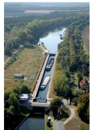
Baufeld Neubau neben Bestandsschleuse
