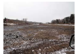
Für Schleusenneubau vorbereitetes Baufeld
