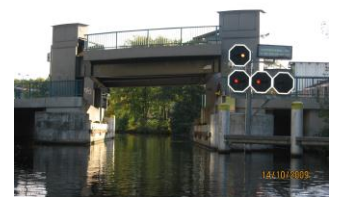
Gehobene Brücke aus Sicht des Finowkanals
