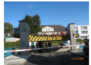
Straßenansicht der gehobenen Brücke
