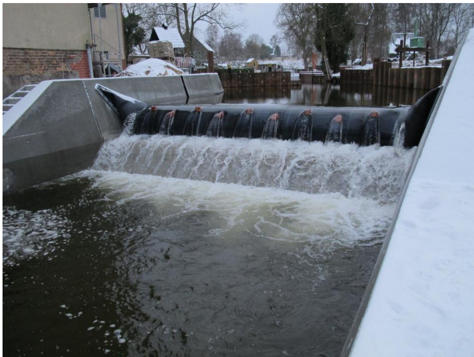
Wasser strömt über das Schlauchwehr Strasen am 17.01.2013
