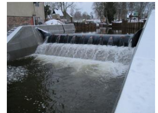
Wasser strömt über das Schlauchwehr Strasen am 17.01.2013
