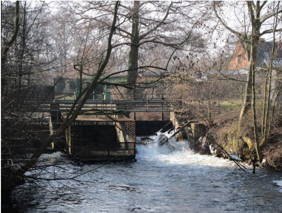
Blick auf die alte Wehranlage vom Unterwasser, März 2011
