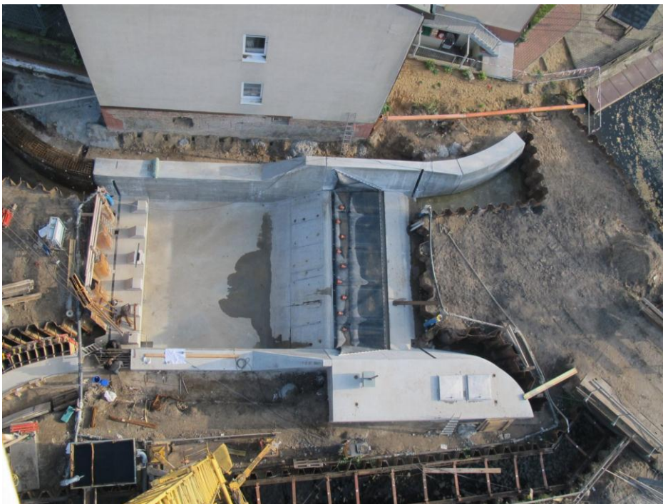
Blick auf die Baustelle von oben, November 2012
