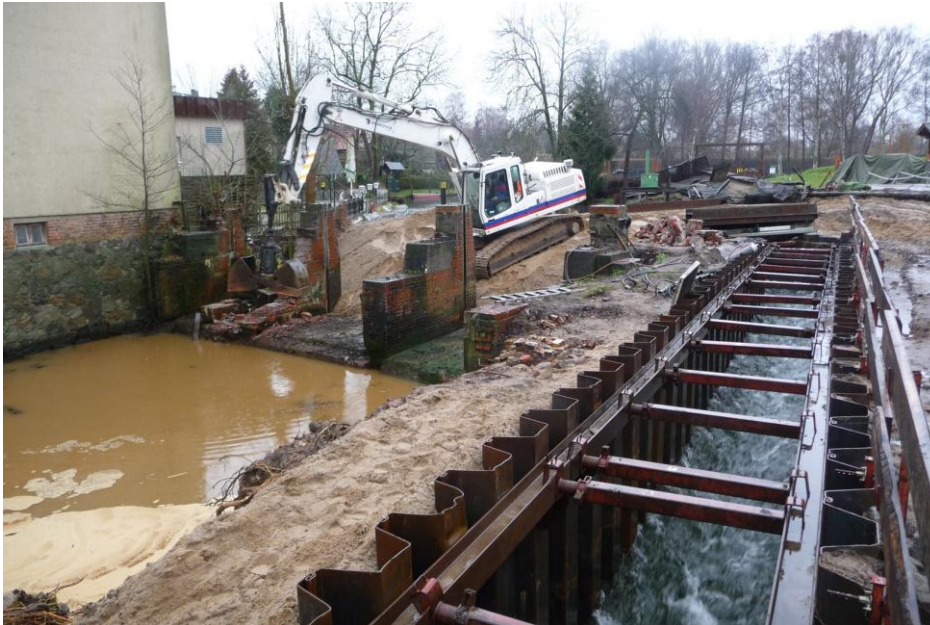
Abriss des alten Wehrs und Umfluter, Januar 2012
