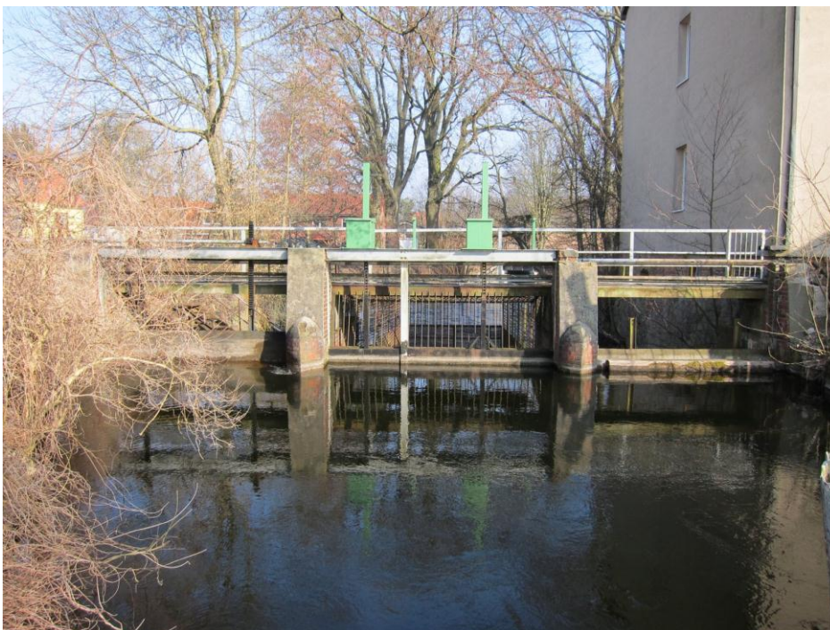
Blick auf die alte Wehranlage vom Oberwasser, März 2011
