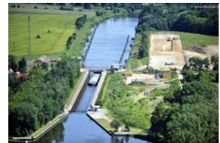
Baufeld Neubau 2. Schleuse Zerben
