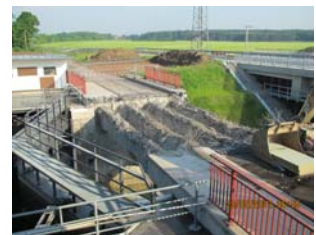
Abbruch Brücke über das Unterhaupt
