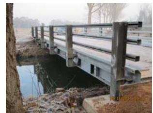
Behelfsbrücke am oberen Wehr
