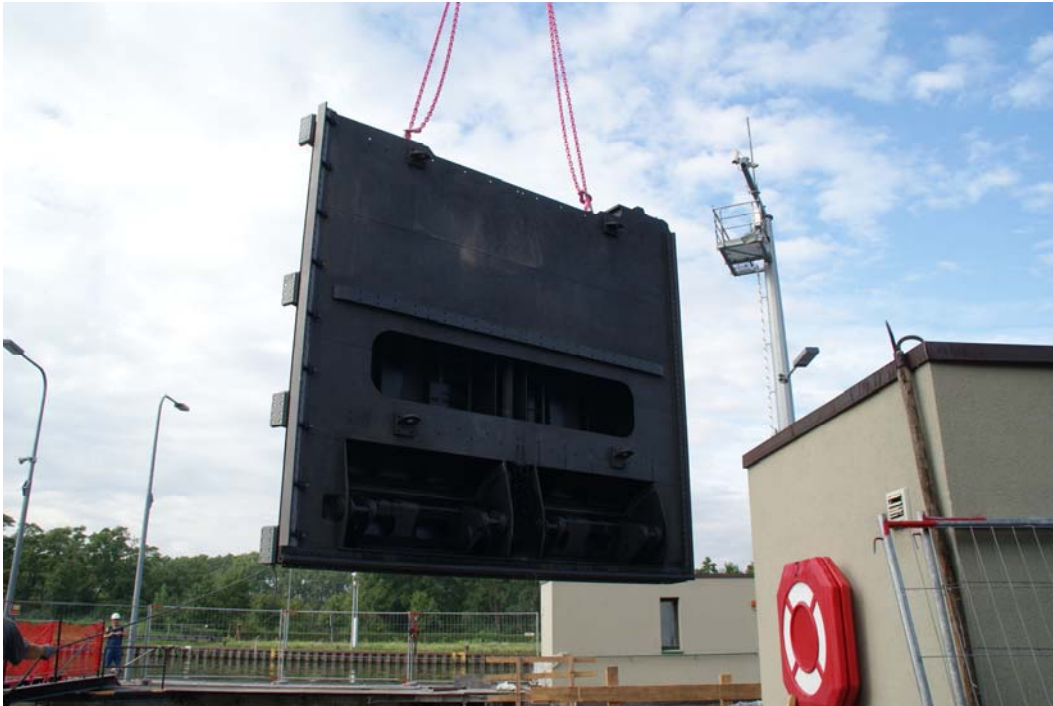
Einhub des (in Flussrichtung) linken Obertors
