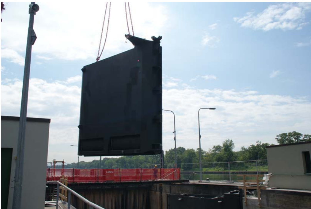
Einhub des (in Flussrichtung) rechten Obertors
