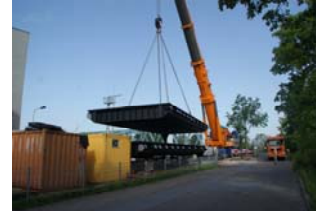
Die größeren Tore für unten an der Schleuse werden entladen
