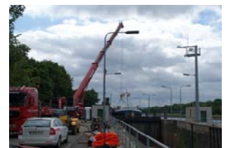
Der 400-Tonnen-Kran hebt ein altes 30-Tonnen Schleusentor in den Frachter
