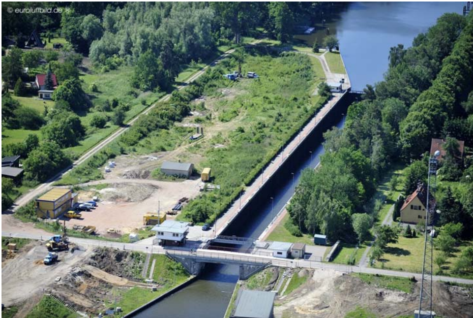
Baufeld 2. Schleuse Zerben direkt südlich der Bestandsschleuse, Luftbild aus Mai 2010 vor Bau der neuen Brücke
