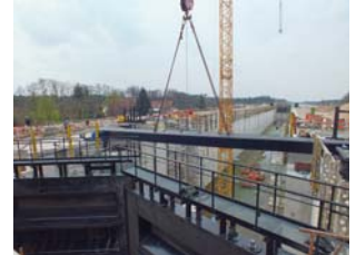
Montage des Stoßschutzbalkens am Untertor
