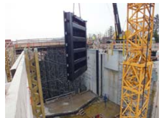
Einhub eines Untertorflügels mittels Mobilkran
