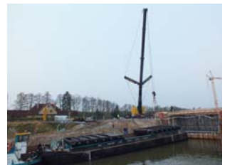
Entladung eines Torflügels aus der Transportschute
