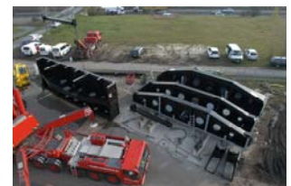
Schleusentor (vor dem Einbau)
