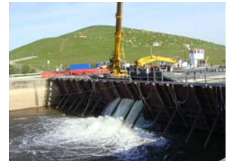
Flutung der Kanaltragbrücke Zenn
