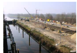
Baustelle Schleuse Düthe
