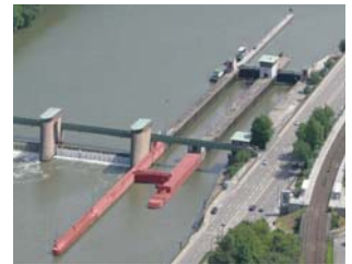
Schleuse Neckargemünd nach der Verlängerung der rechten Schleusenkammer nach Unterwasser
