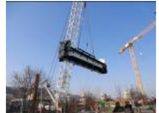
Einheben eines Wehrverschlusses
