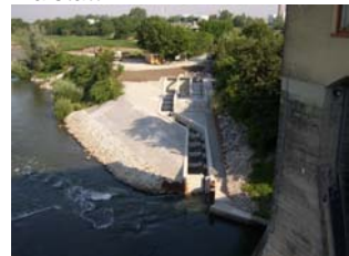
Neue Fischaufstiegsanlage Ladenburg
