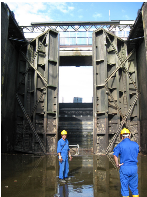
Ingenieure bei der Inspektion von Stemmtoren
