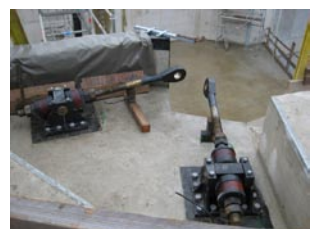
Halslager vor dem Toreinbau
