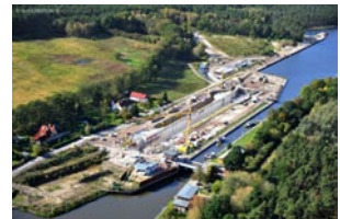
Luftbild der Schleusenbaustelle Oktober 2011
