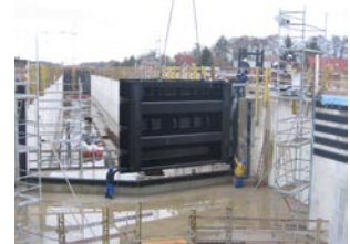
Einheben des ersten Torflügels
