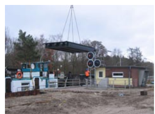
Entladen eines Torflügels aus dem Binnenschiff
