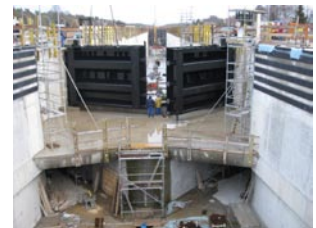
Blick vom Einfahrtbereich Oberhaupt Richtung Obertor zum Abschluss der Tormontage
