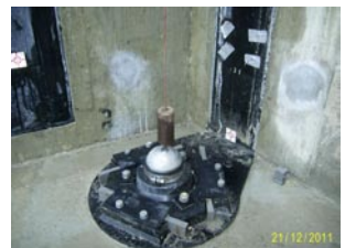
Spurlager vor dem Toreinbau
