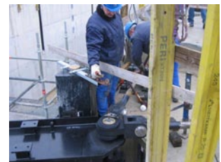
Einstellarbeiten am Halslager
