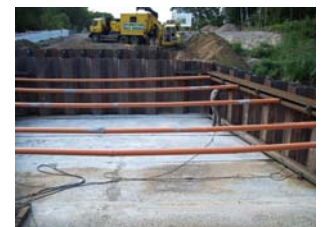
Bauzustand Widerlager B08a im Sept. 2010
