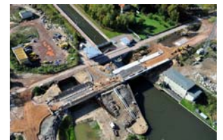
Luftbild Okt. 2011 – Neuer Brückenzug B08 unterwasserseitig der bisherigen Straße
