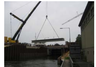
Montage der Brückenüberbauten B08 am 21. Juli 2011
