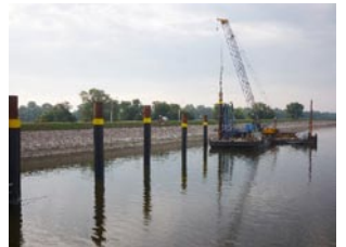
Dalbenrammung östliches Leitwerk Unterwasser
